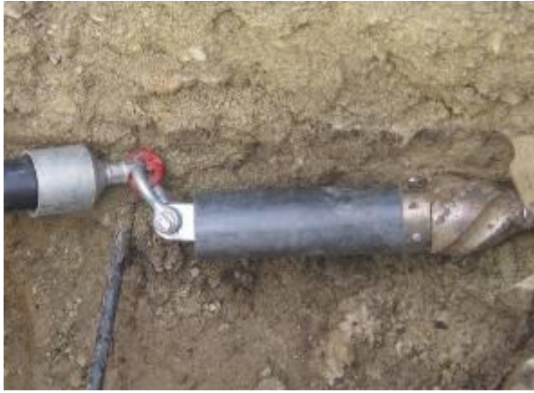
Genişletici ve yeni boru, boru çekme işleminden hemen önce.
