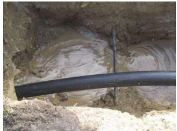
Boru çekilmesi esnasında, bentonit çamuru açılan delikten sürekli olarak akmaktadır.
